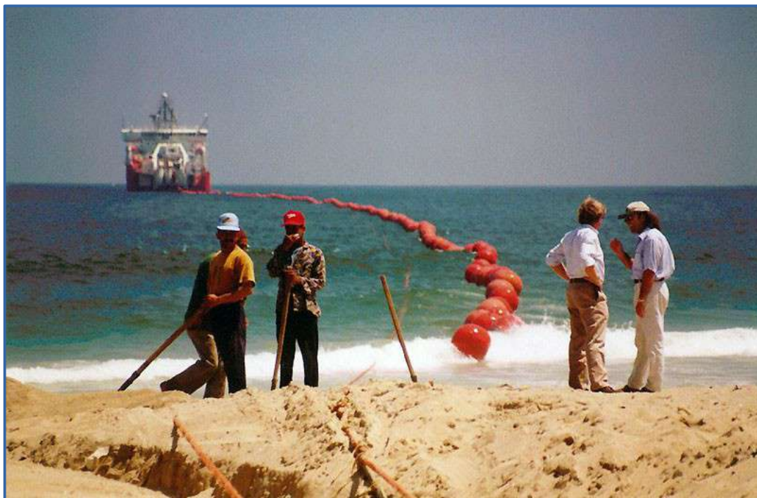
↑ Atterrissage d'un câble sous-marin. © Wikimedia Commons
